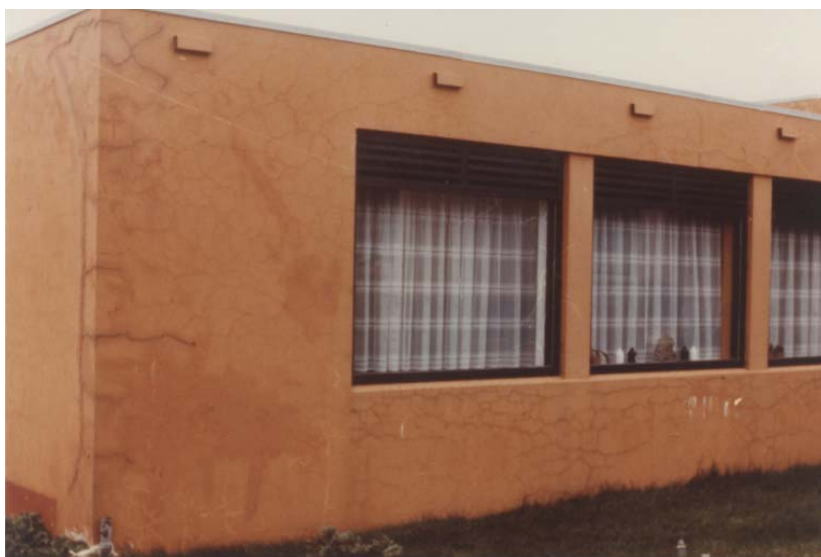
Mynd 3. Fyrsta húsið þar sem alkalískemmdir fundust. Sjá má útbreytt sprungunet.
